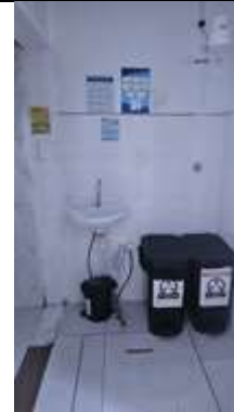
Contenedor para residuos sanitarios y contenedores para pañales de baño con ducha para cambio de pañal
